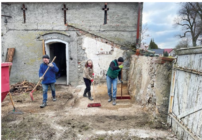
1000 Stunden Handwerksarbeit wurden bereits geleistet, vor allem durch die Mönche in ihrer Freizeit, aber auch durch freiwillige Helfer, die uns bei der Sanierung des Bernhardshofs unterstützen.
